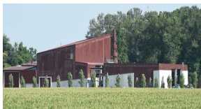
Impianto di biomasse
